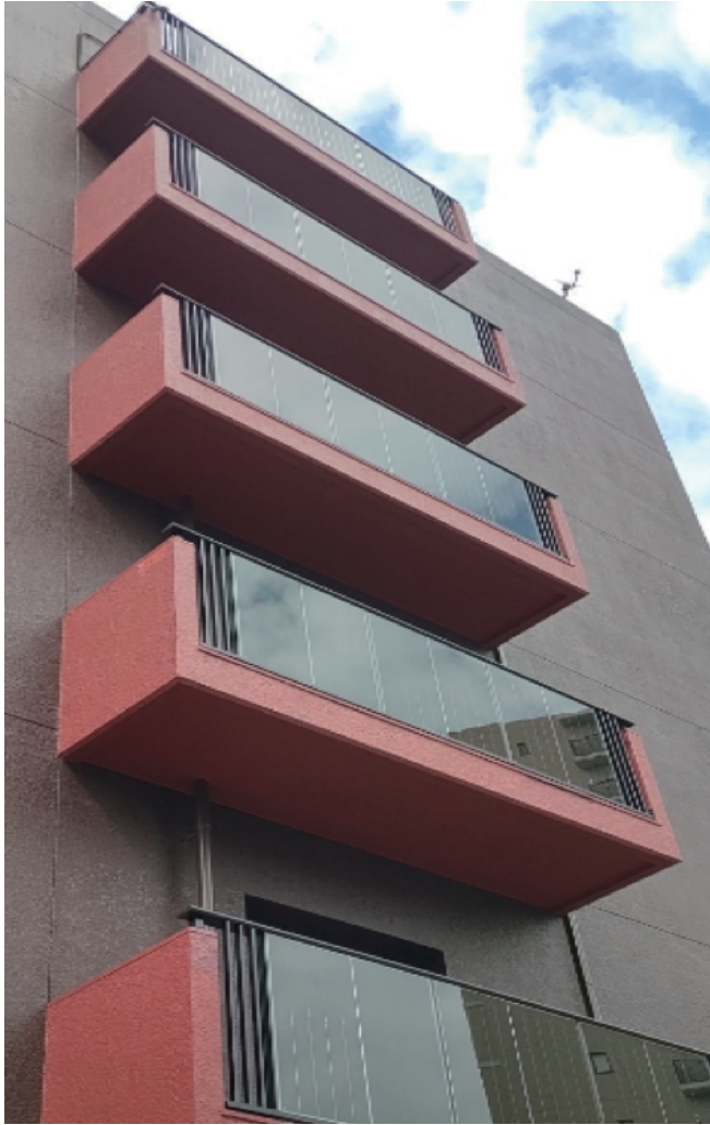
熊本県某物件 (改修工事)
